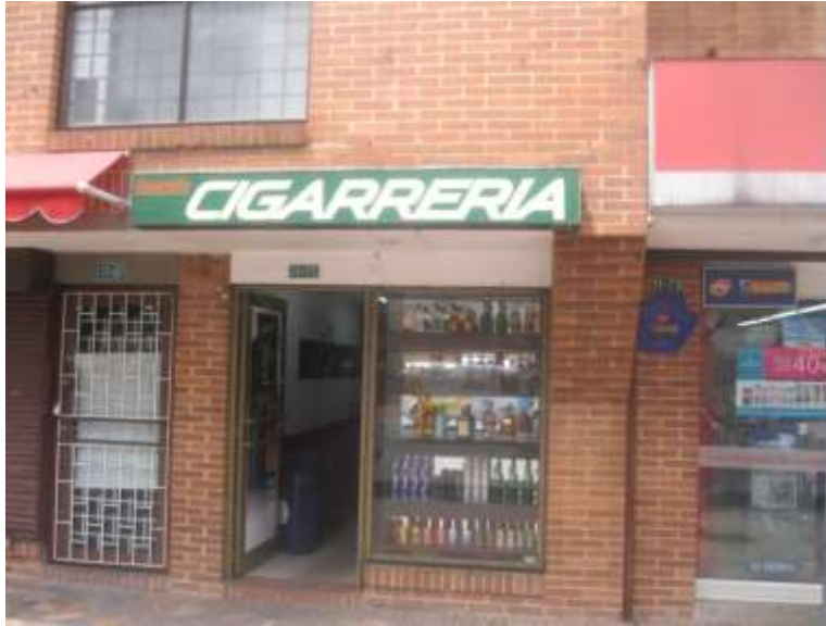
Fotografía No. 1 : Aviso AMARETTO CIGARRERIA ubicado en la Calle 67 No. 11 - 71. No cuenta con Registro de Publicidad Exterior Visual. La ubicación está en fachada no perteneciente al local y/o la fachada no es la fachada de un local comercial
